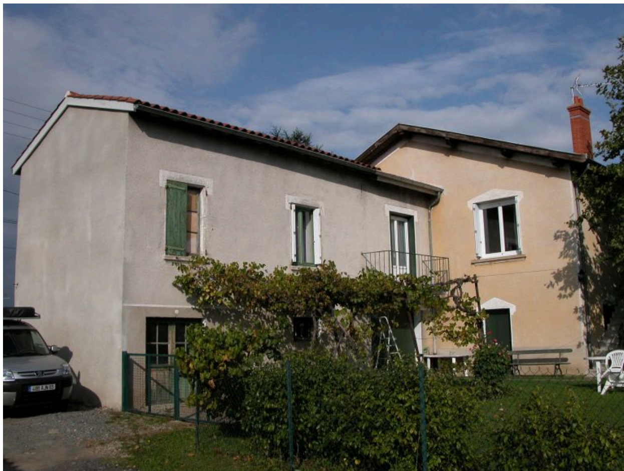
Vue d'ensemble des bâtiments depuis le clos.
