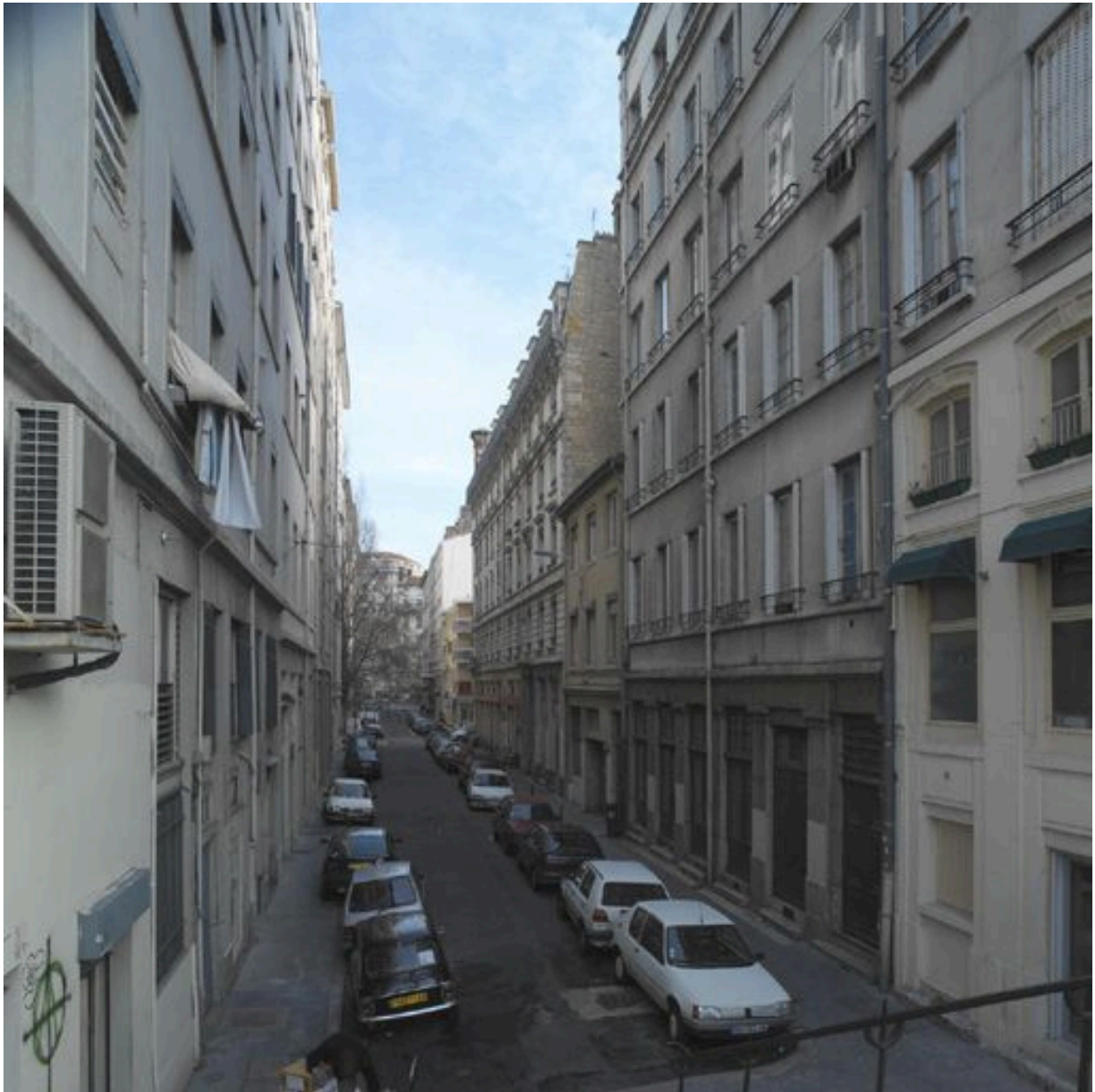
Vue d'ensemble depuis le sud
