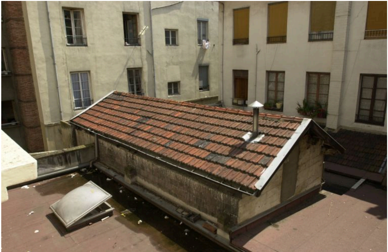
Détail des constructions dans la cour, l'atelier de charcuterie artisanale
