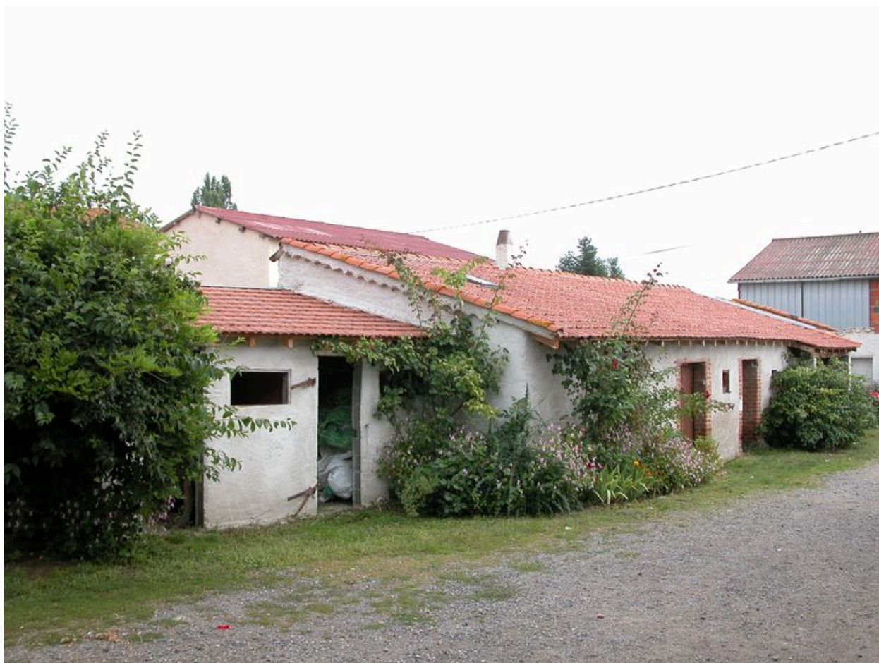
Vue d'ensemble de la seconde porcherie avec la chaudière.
