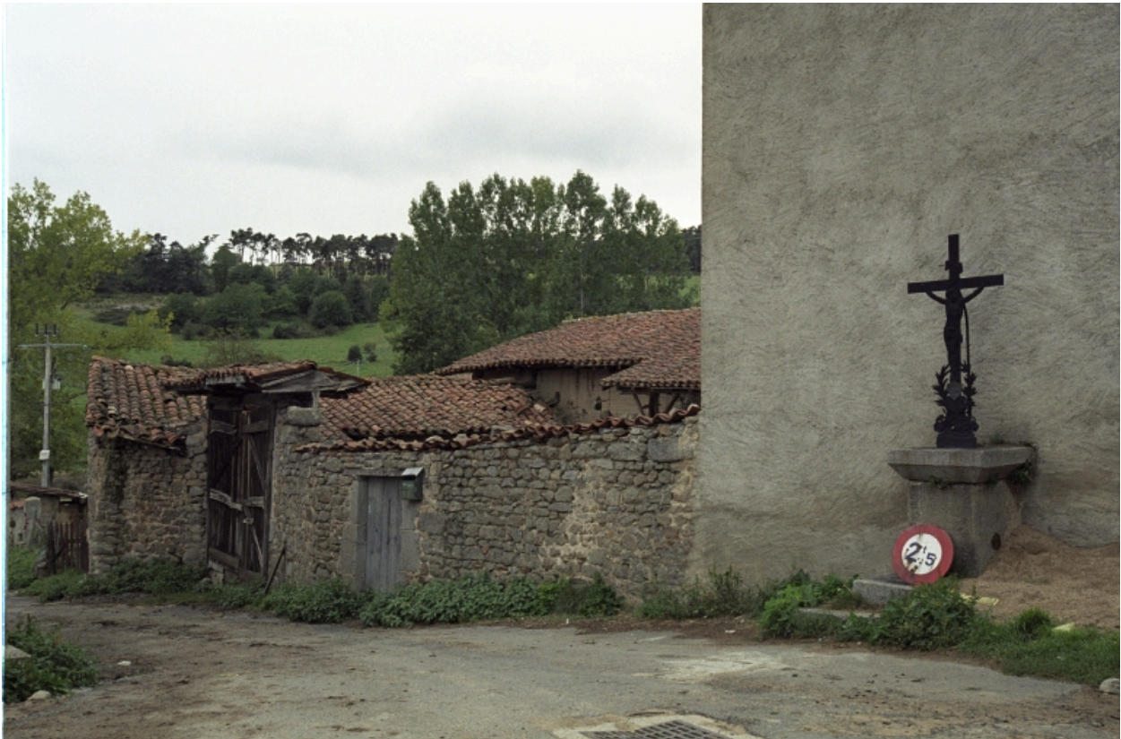
Vue d'ensemble depuis le carrefour, du nord.
