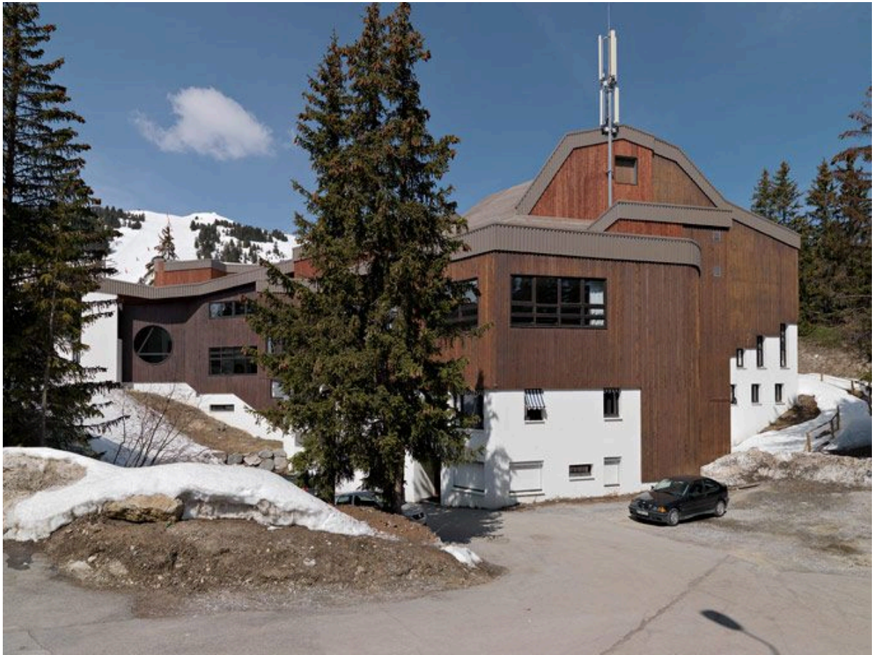
L'auditorium depuis le nord
