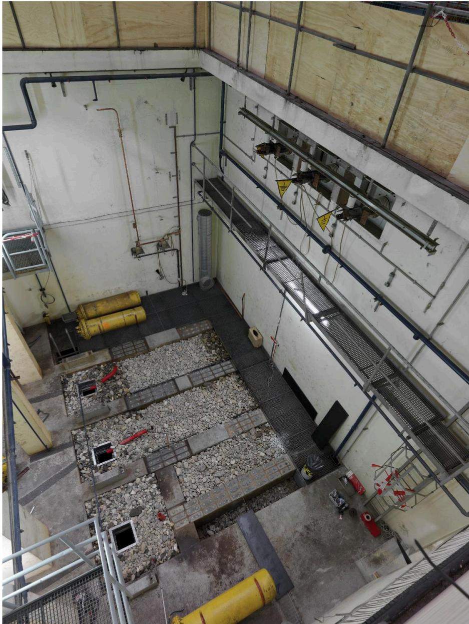
Fosse recevant le transformateur 15 kV/400 kV du groupe 6 en cours de remplacement
