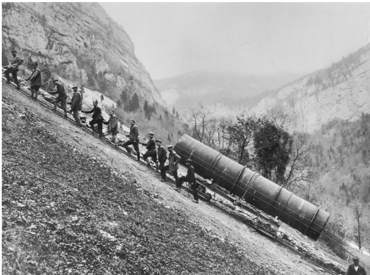
Conduite forcée de l'usine Bouchayer-Viallet (AD 38)
