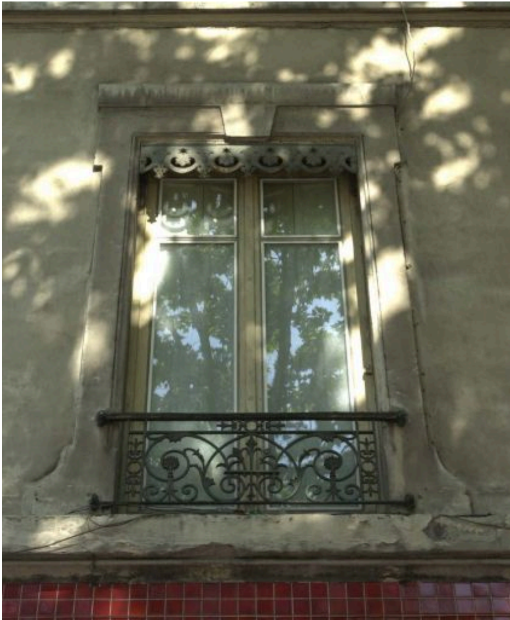
Détail d'une fenêtre, élévation sur cour
