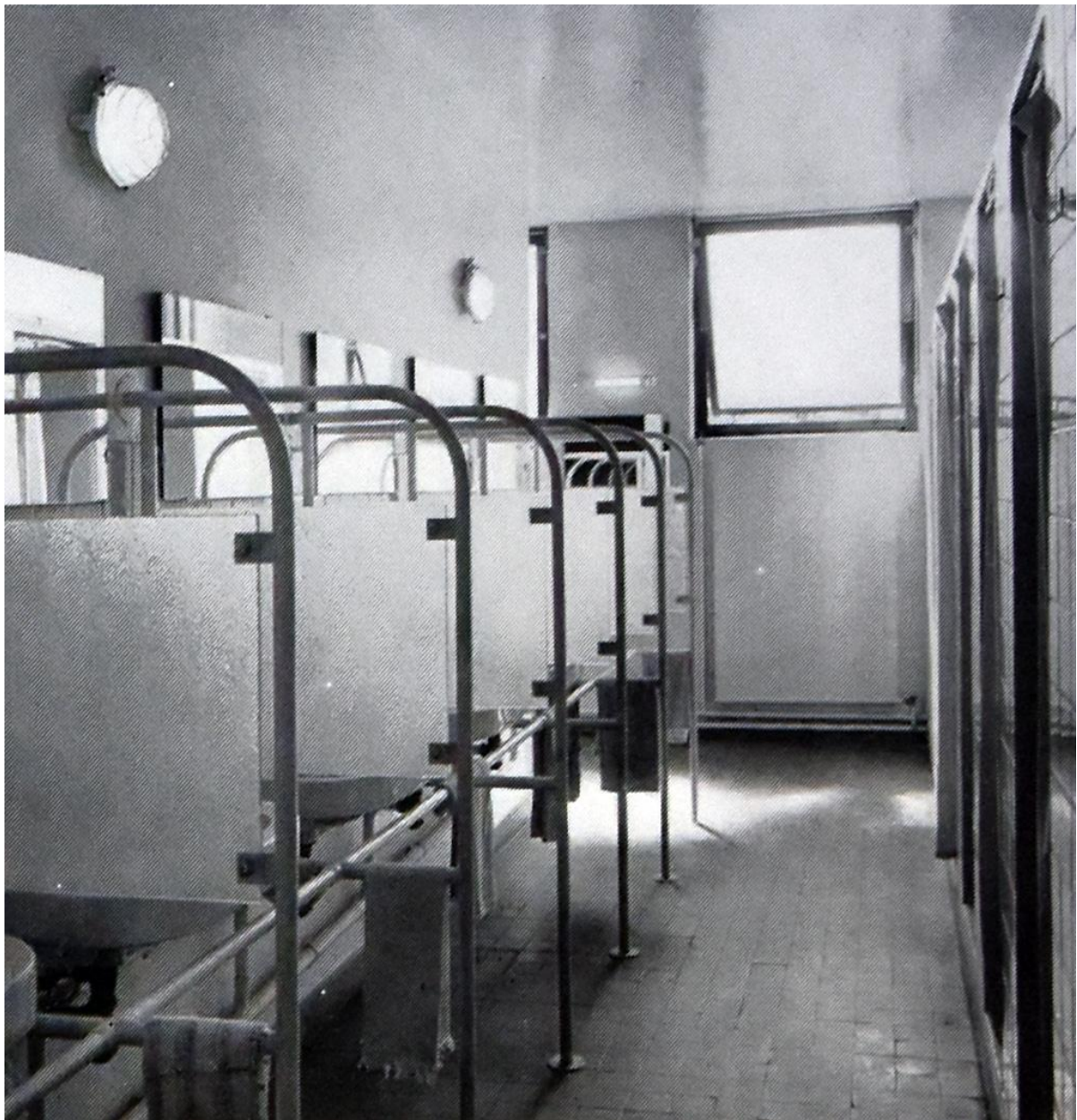
Une salle de douches/lavabos v. 1961 (Phot. Littoz-Baritel In Noviant, Internat du lycée de garçons, 1963)
