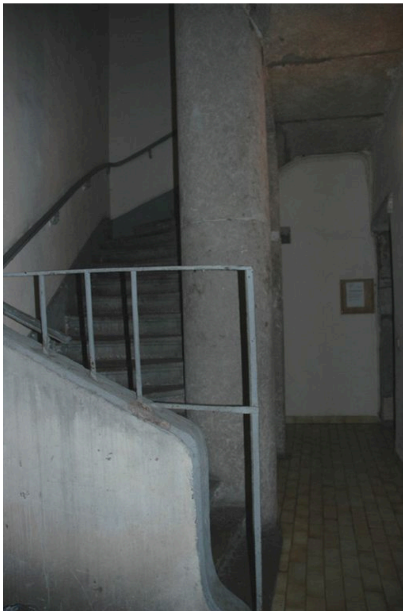
Couvent : 2 rue des Templiers, départ du noyau de l'escalier
