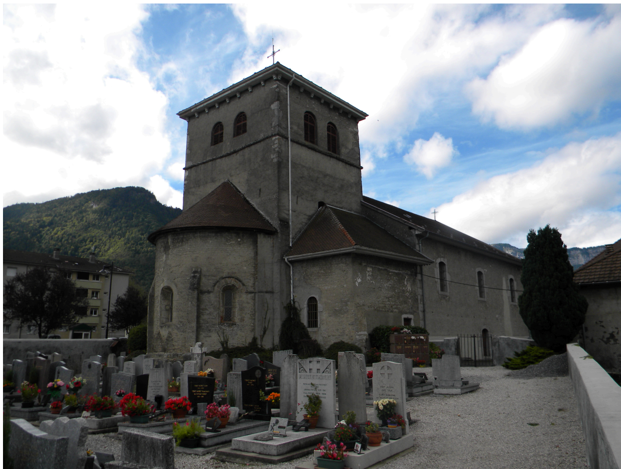
Vue de trois-quarts nord-est depuis le cimetière.
