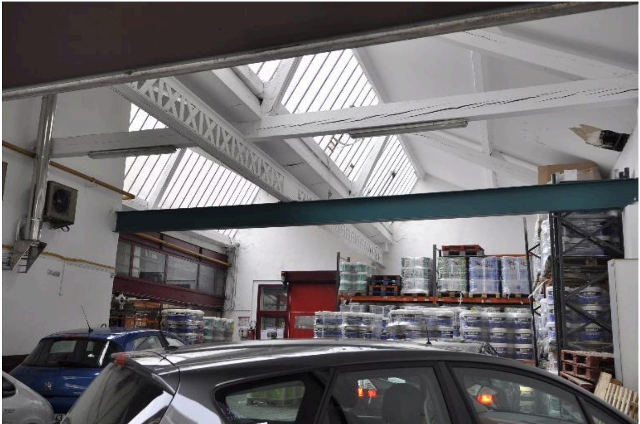
Vue de la charpente en bois
