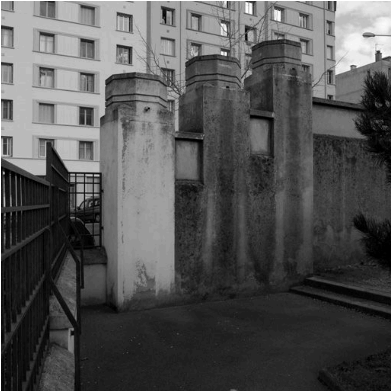
Piles du mur d'enceinte oriental, au sud de l'entrée des véhicules rue Viala
