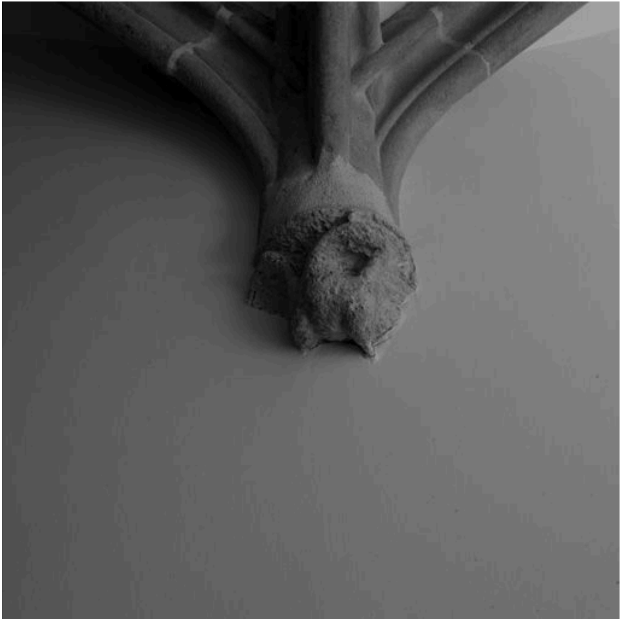
Voûte de l'allée, détail du culot 5
