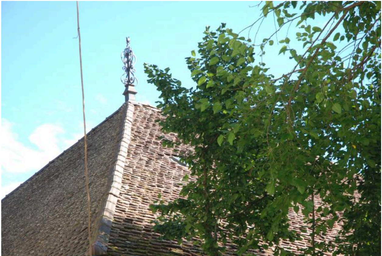
Détail : épi de faîtage.
