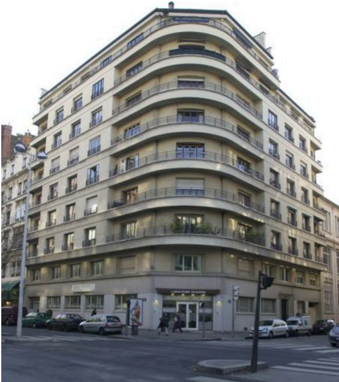
Vue générale de l'élévation
