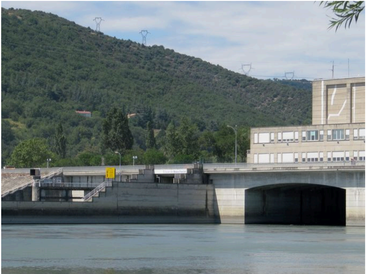
Evacuateur et écluse, face aval (depuis la rive gauche)
