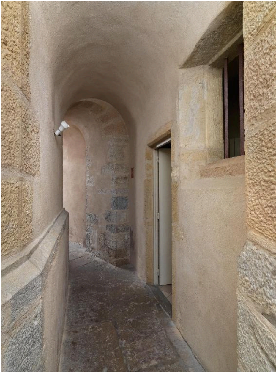
Déambulatoire, partie sud-est
