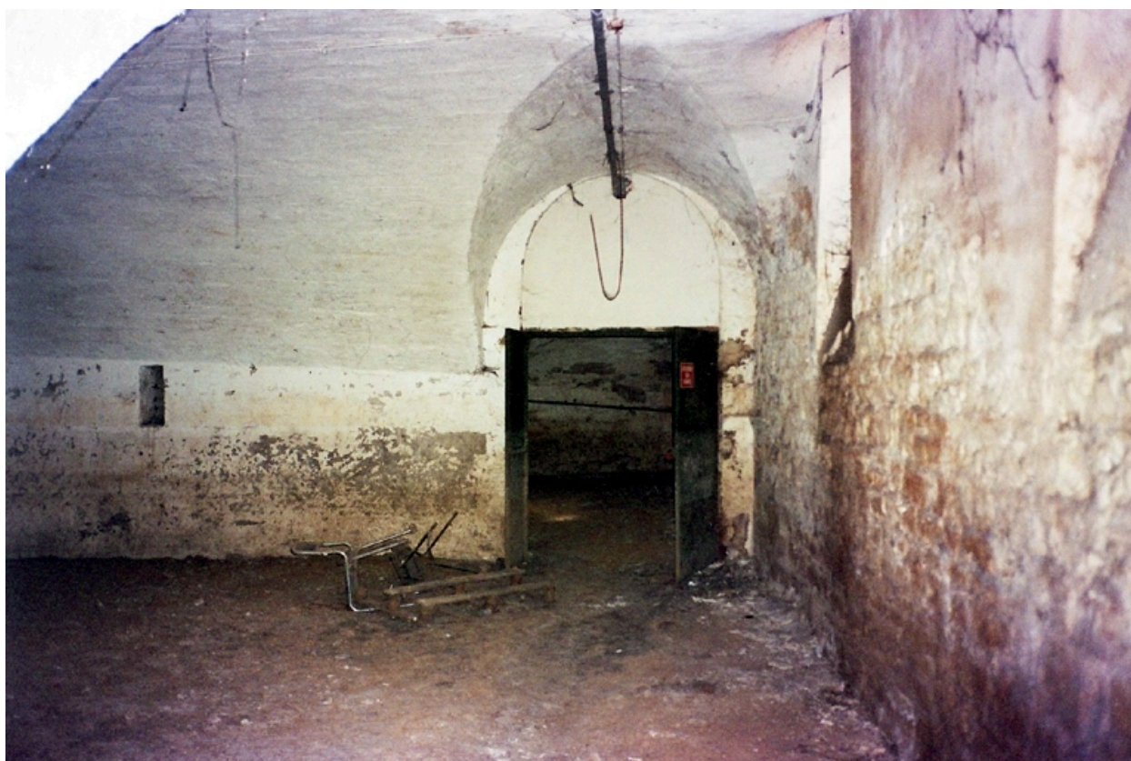
Porte de communication entre caves
