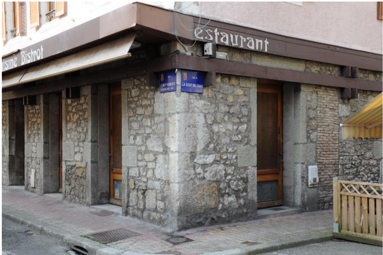
Appareil du rez-de-chaussée, chaîne d'angle en pierre et encadrement en molasse
