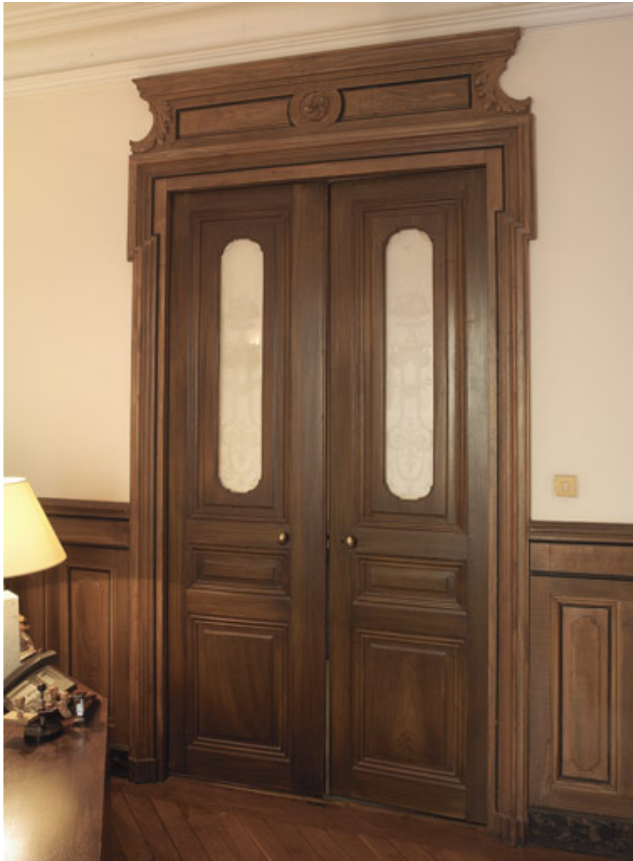
Porte d'accès à l'ancienne salle à manger : battants en verre gravé à motifs de soupières.
