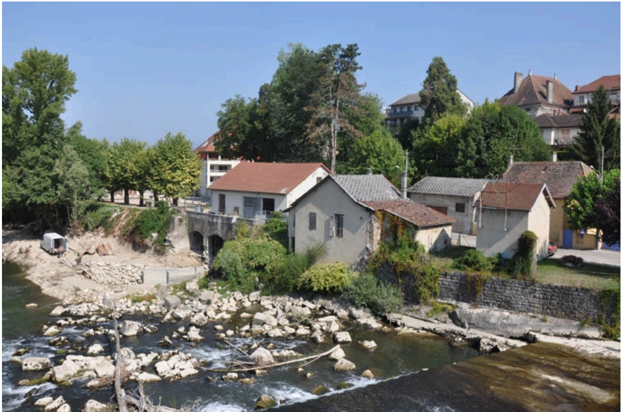
Vue générale de la centrale hydroélectrique, du logement et du transformateur, façade sud-ouest
