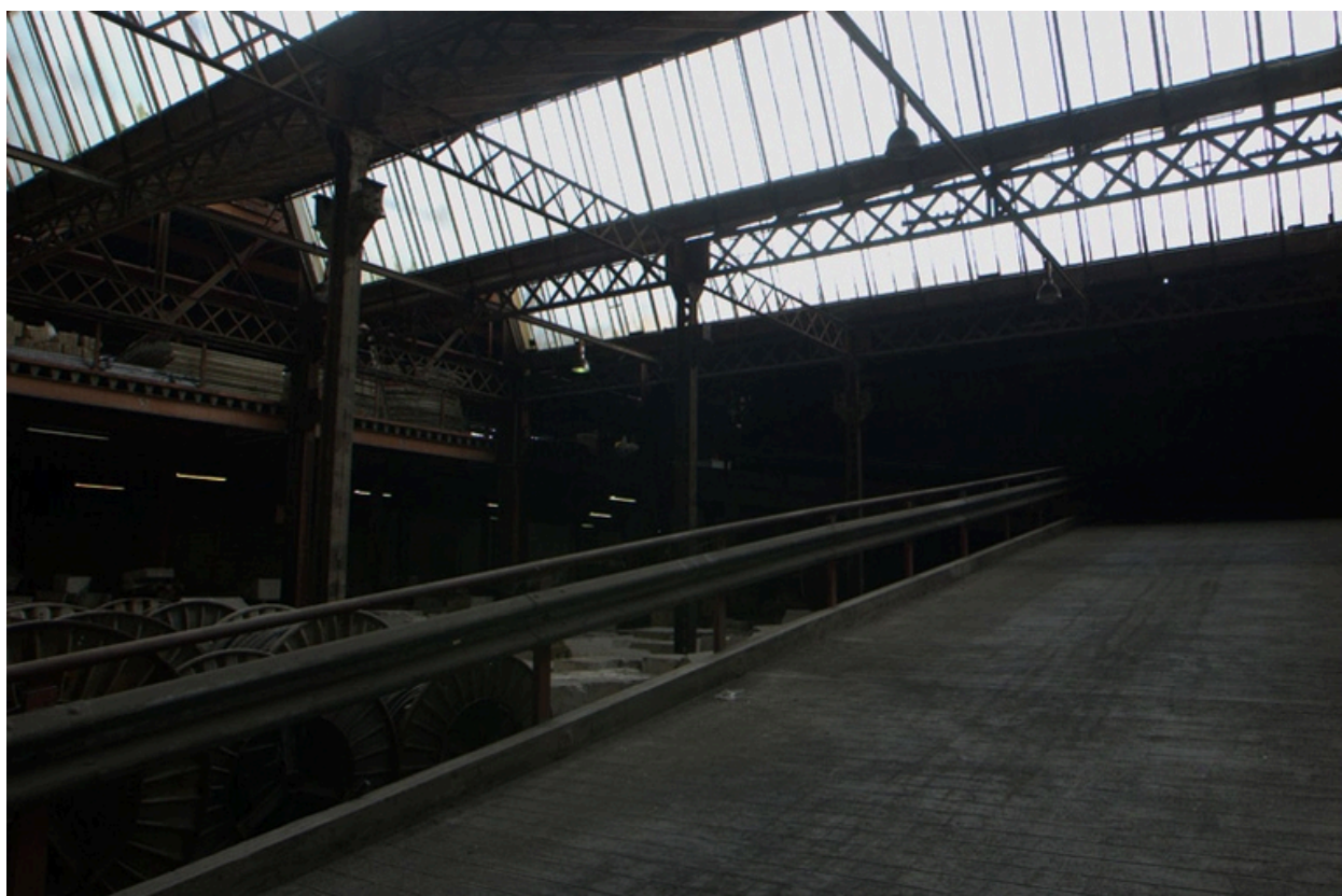
Détail rampe automobile
