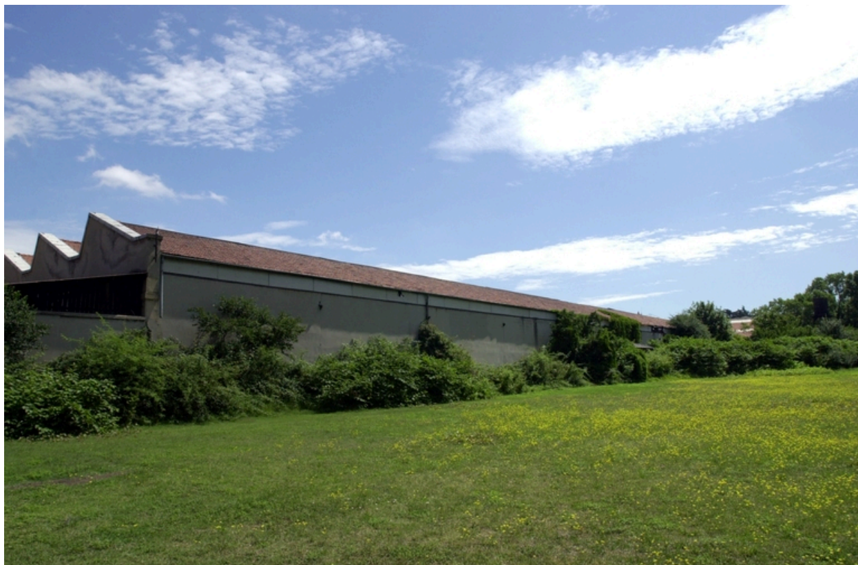
Vue sud-est du site
