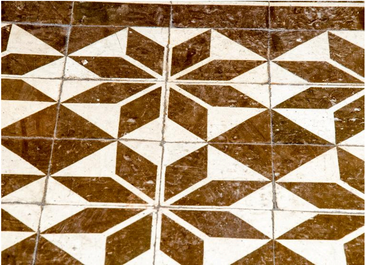
Sol en carreaux de ciment : détail
