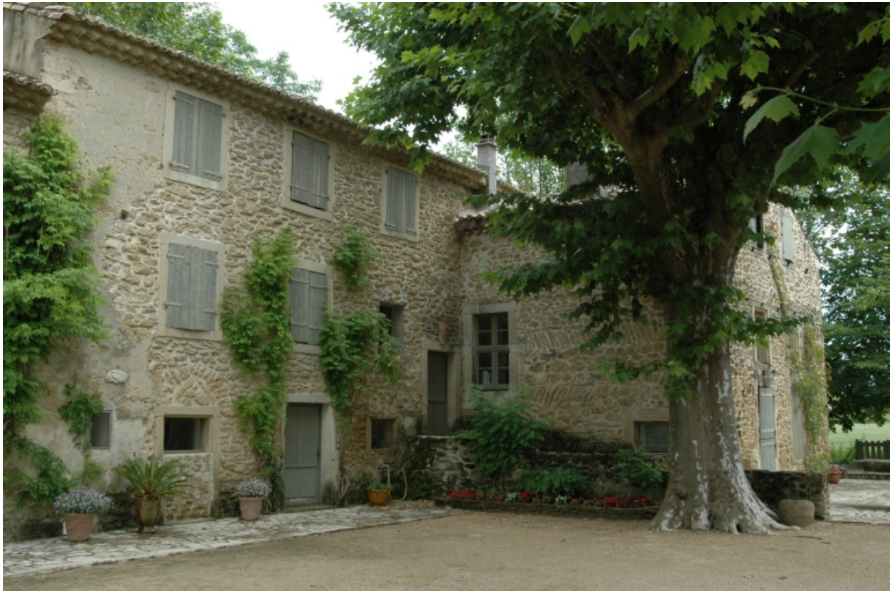
Les Fournaches. Vue sud du logis du moulin.
