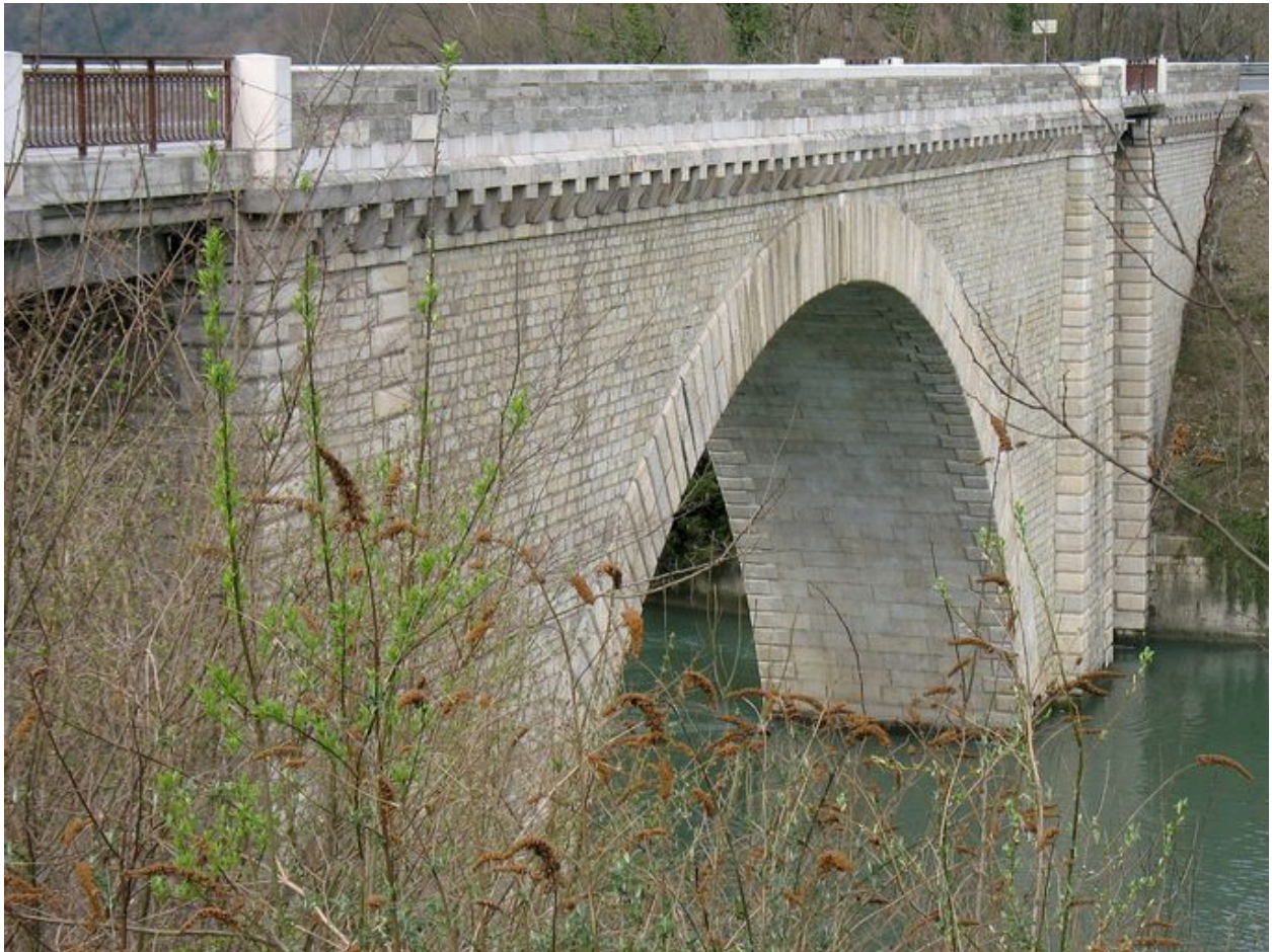
Vue de l'arche centrale de 3/4, face amont (depuis la rive gauche)
