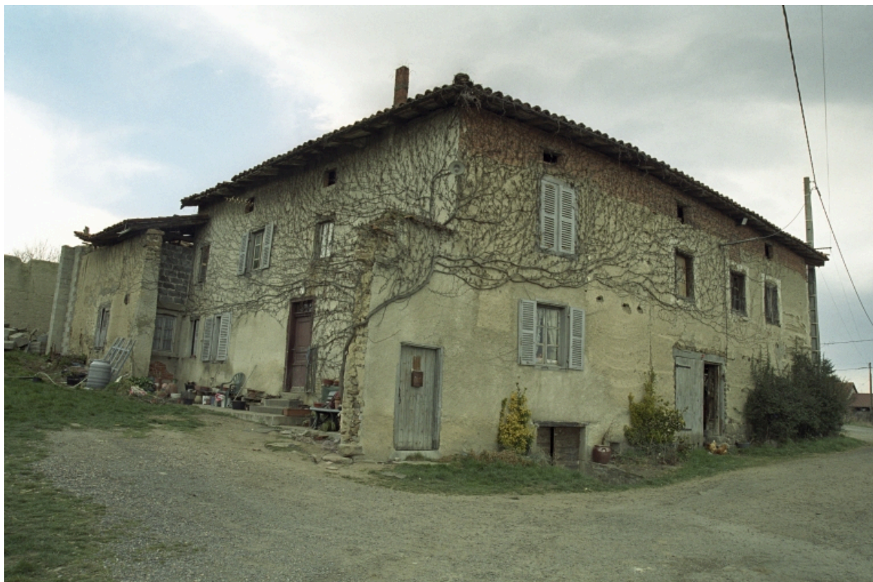
Trelins, le Clos (1986 B4 1159). Type A2. Vue d'ensemble de la ferme.
