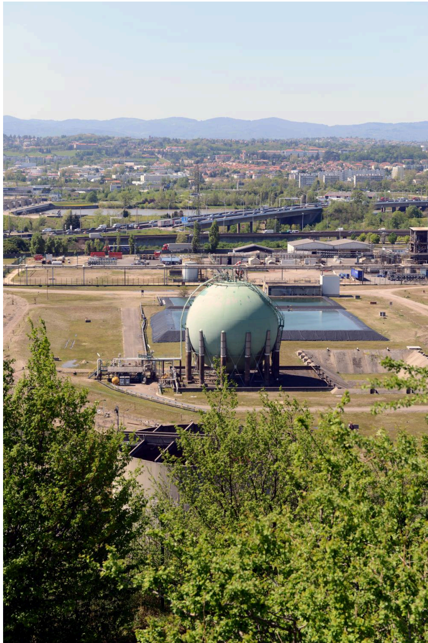
Réservoir sphérique et bassins de rétention, Saint-Fons, 2016 (©Métropole de Lyon)
