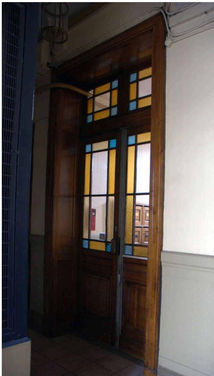
Porte du sas, depuis la cage d'escalier
