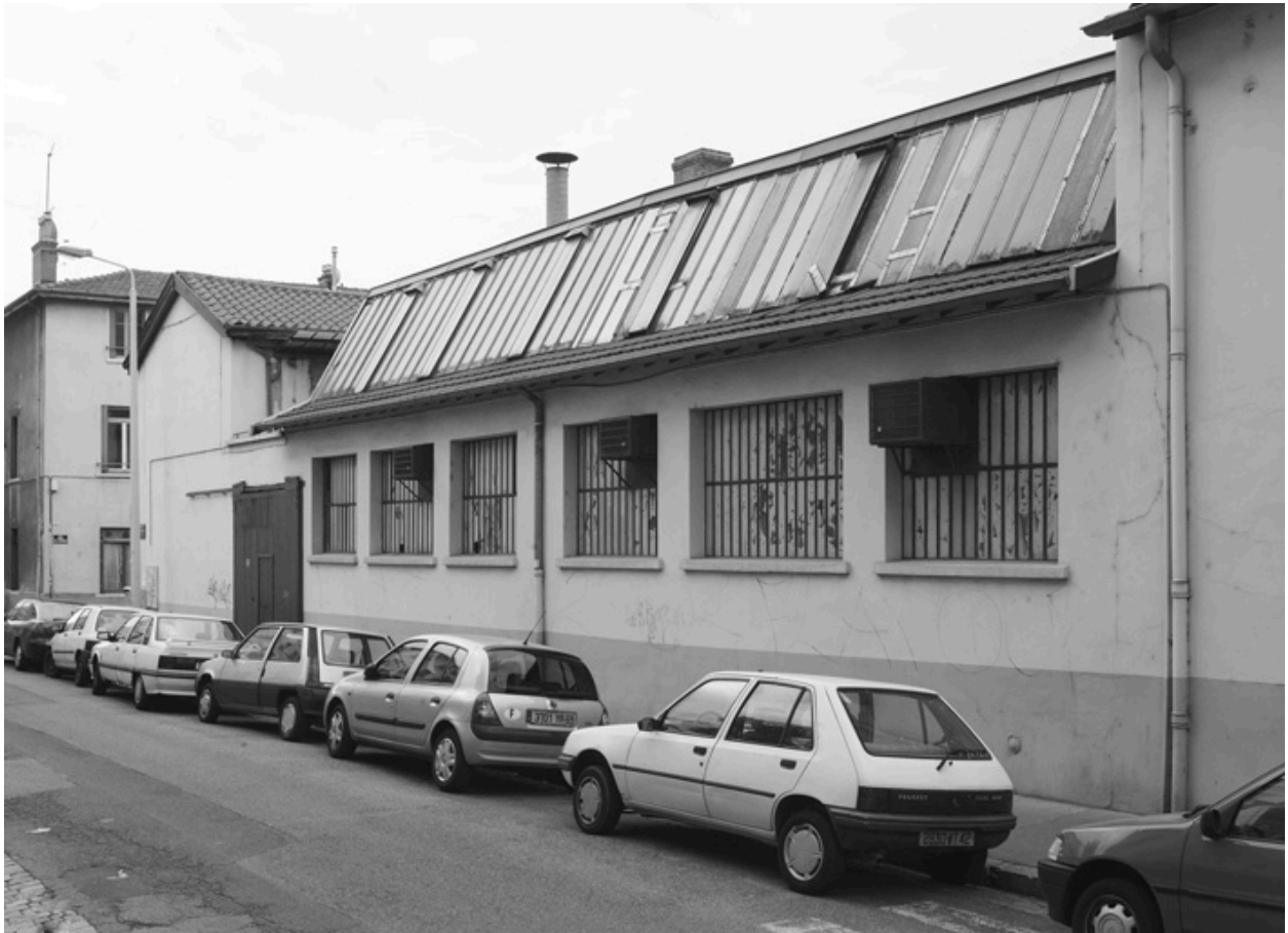
Façade des ateliers nord
