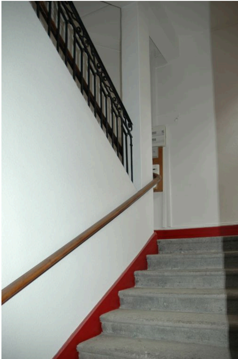
Vue partielle de l'escalier tourant à retours sans jour.
