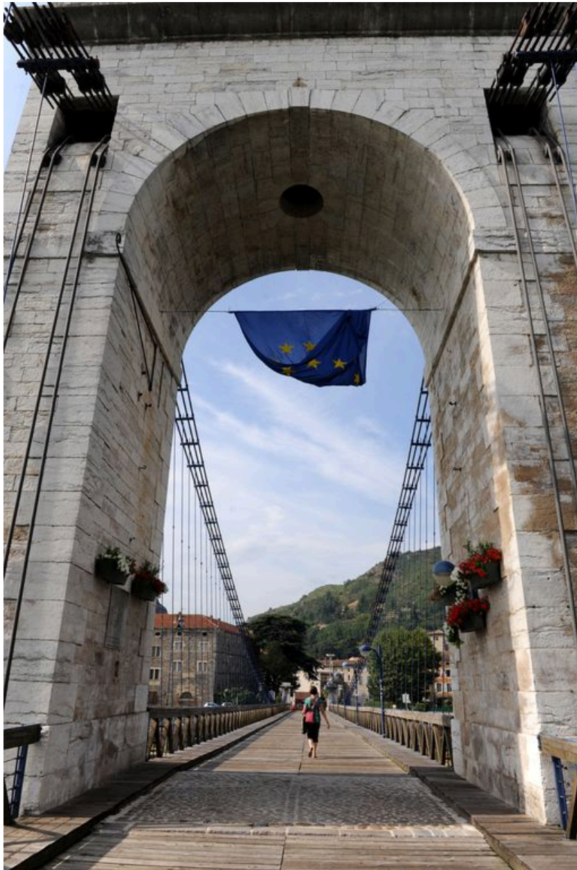
Pile centrale, vue partielle : ancrages des câbles porteurs (depuis la rive gauche)
