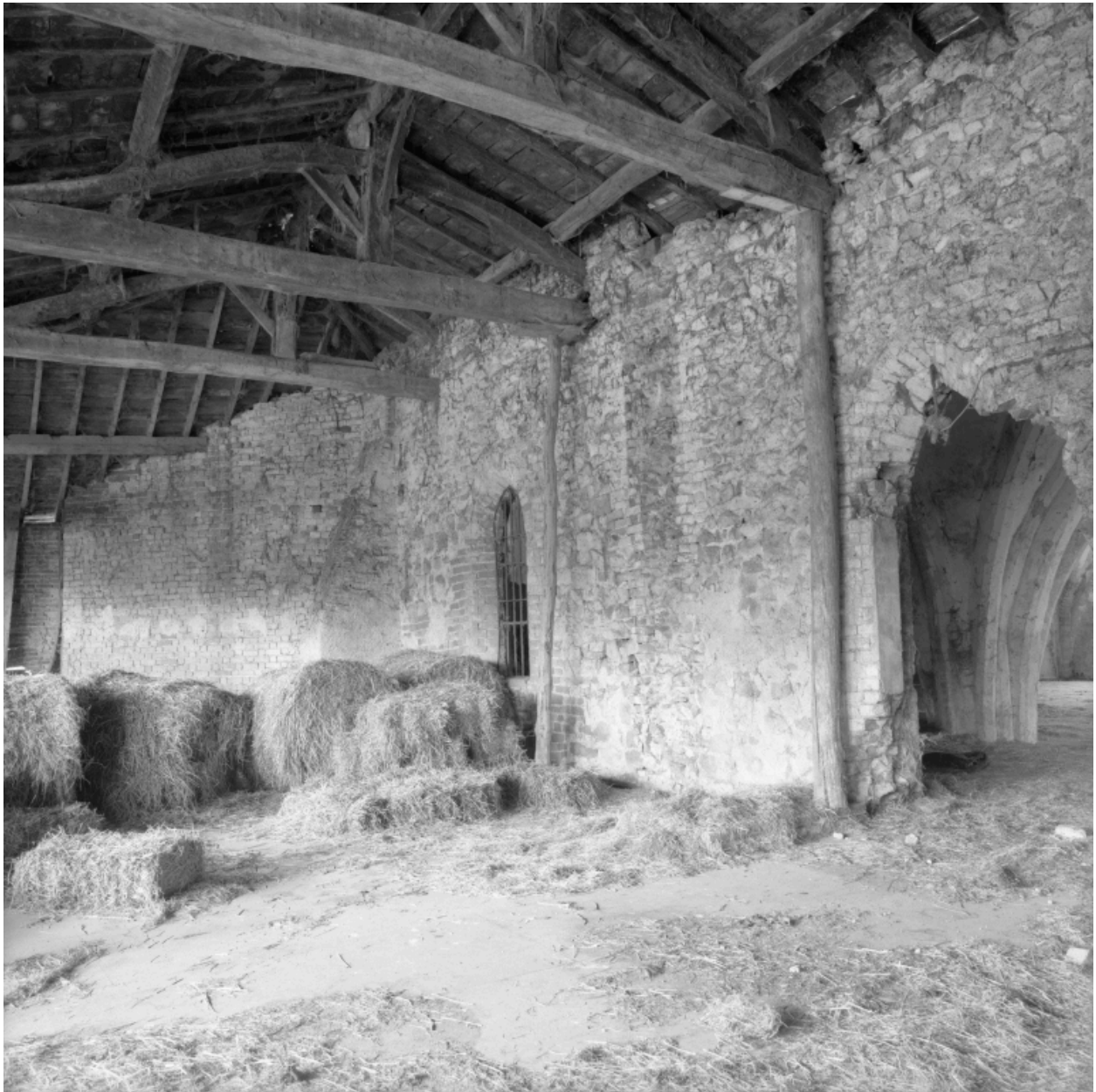
Façade nord, détail de la partie orientale.
