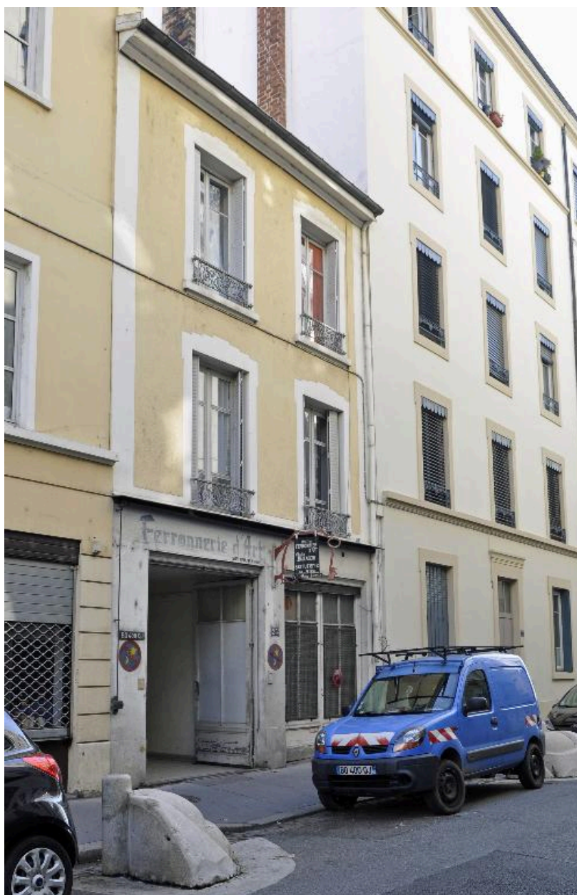
Bâtiment sur rue, vue générale
