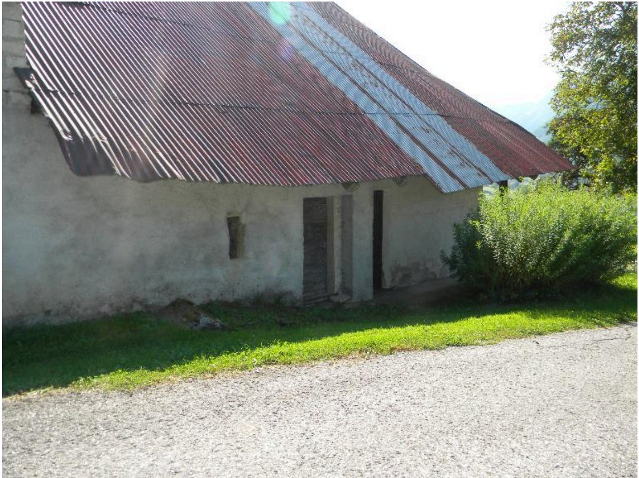
Vue de la façade nord du logis
