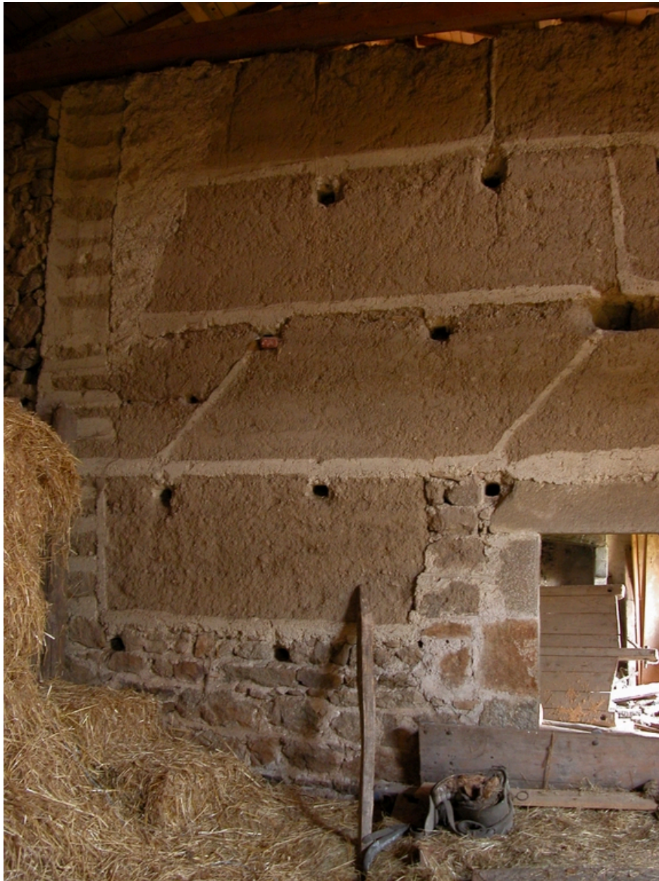
Vue du mur de refend entre la grange et la cuisine (depuis la grange).
