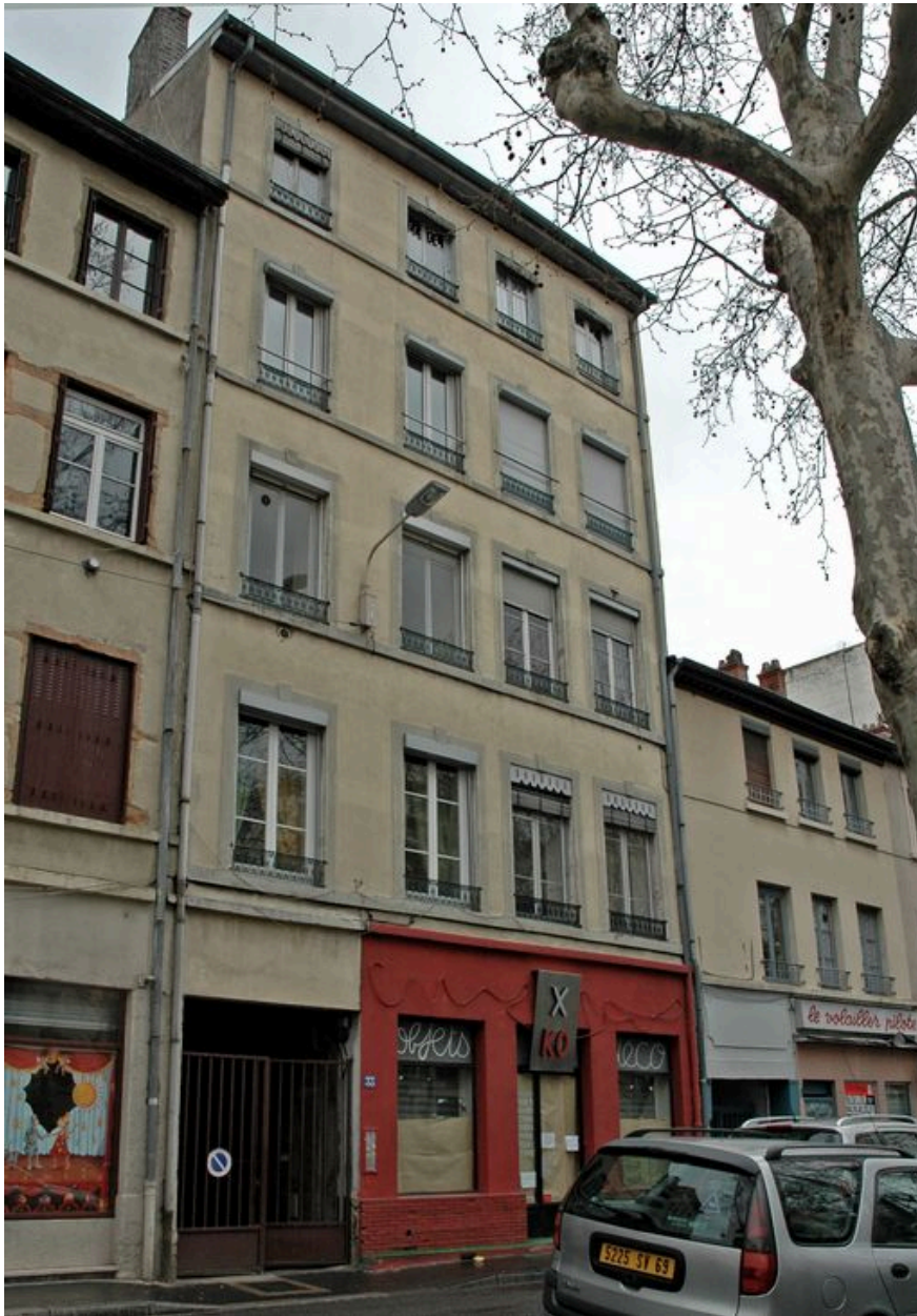
Façade sur le rue Claude-Boyer vue depuis le nord-ouest
