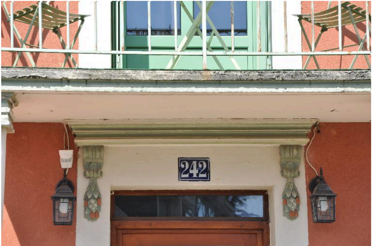
Ornements encadrant la porte d'entrée
