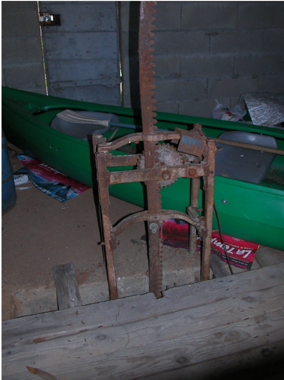
Vue intérieure du bâtiment 1984 B 44 : vanne de vidange de l'étang.
