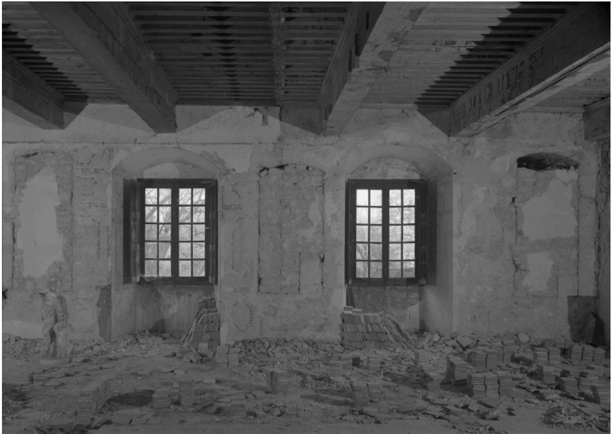
Salle du 2e étage, élévation intérieure ouest.
