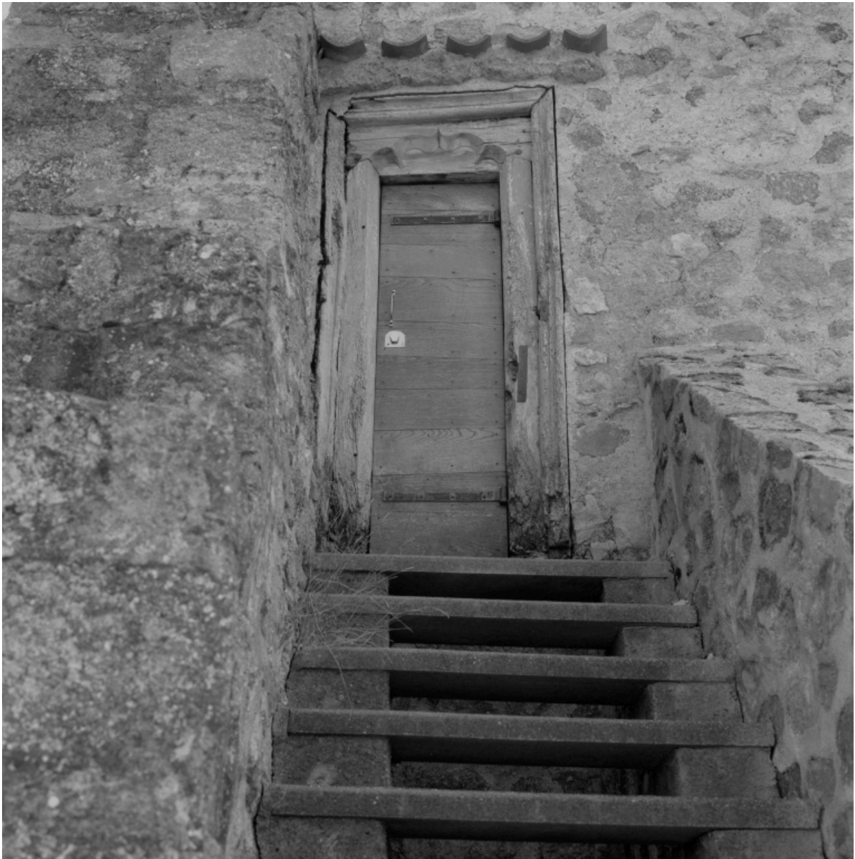
Détail de la porte nord (accès au clocher).
