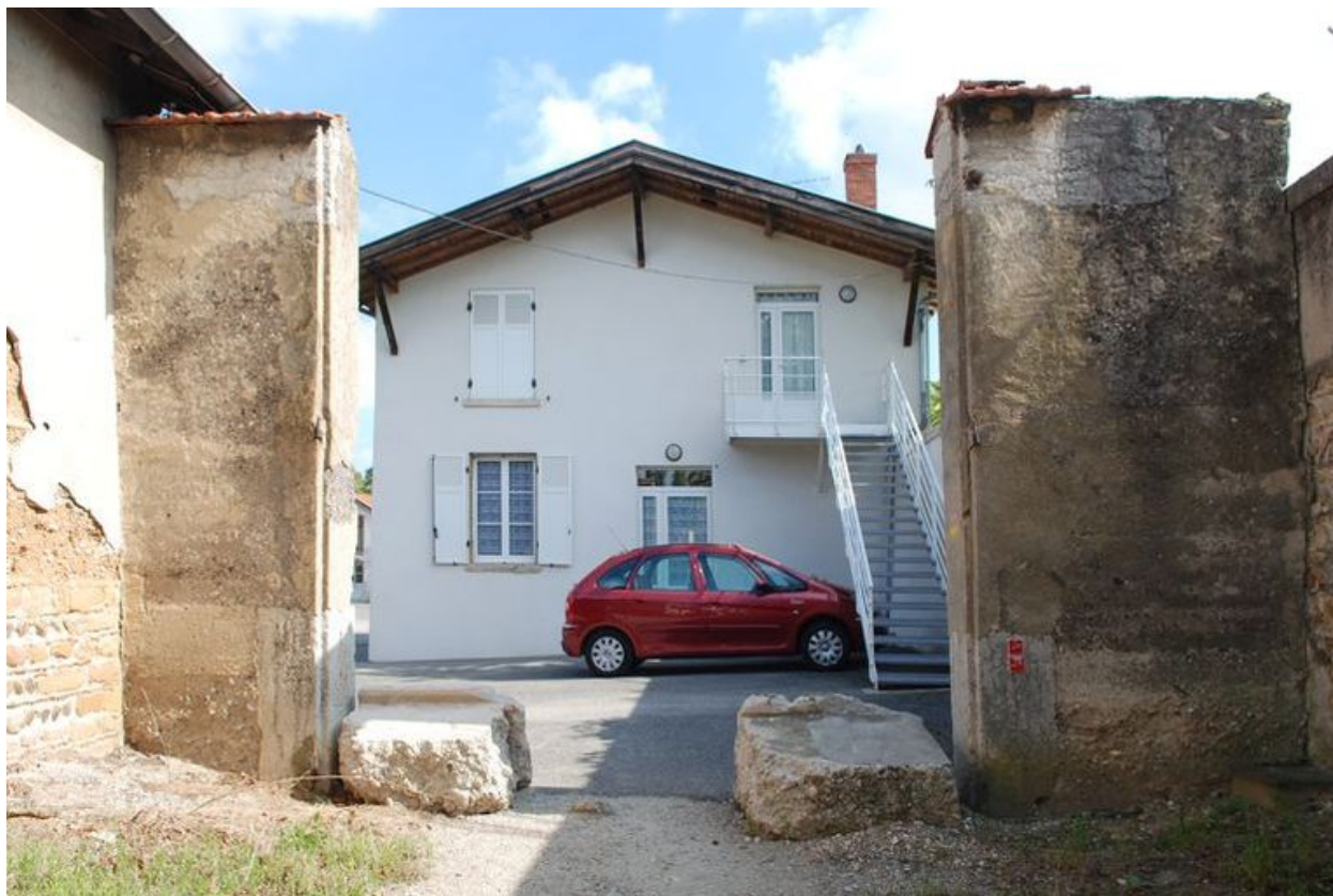
Bâtiment 234, ancienne étable d'isolement, façade ouest
