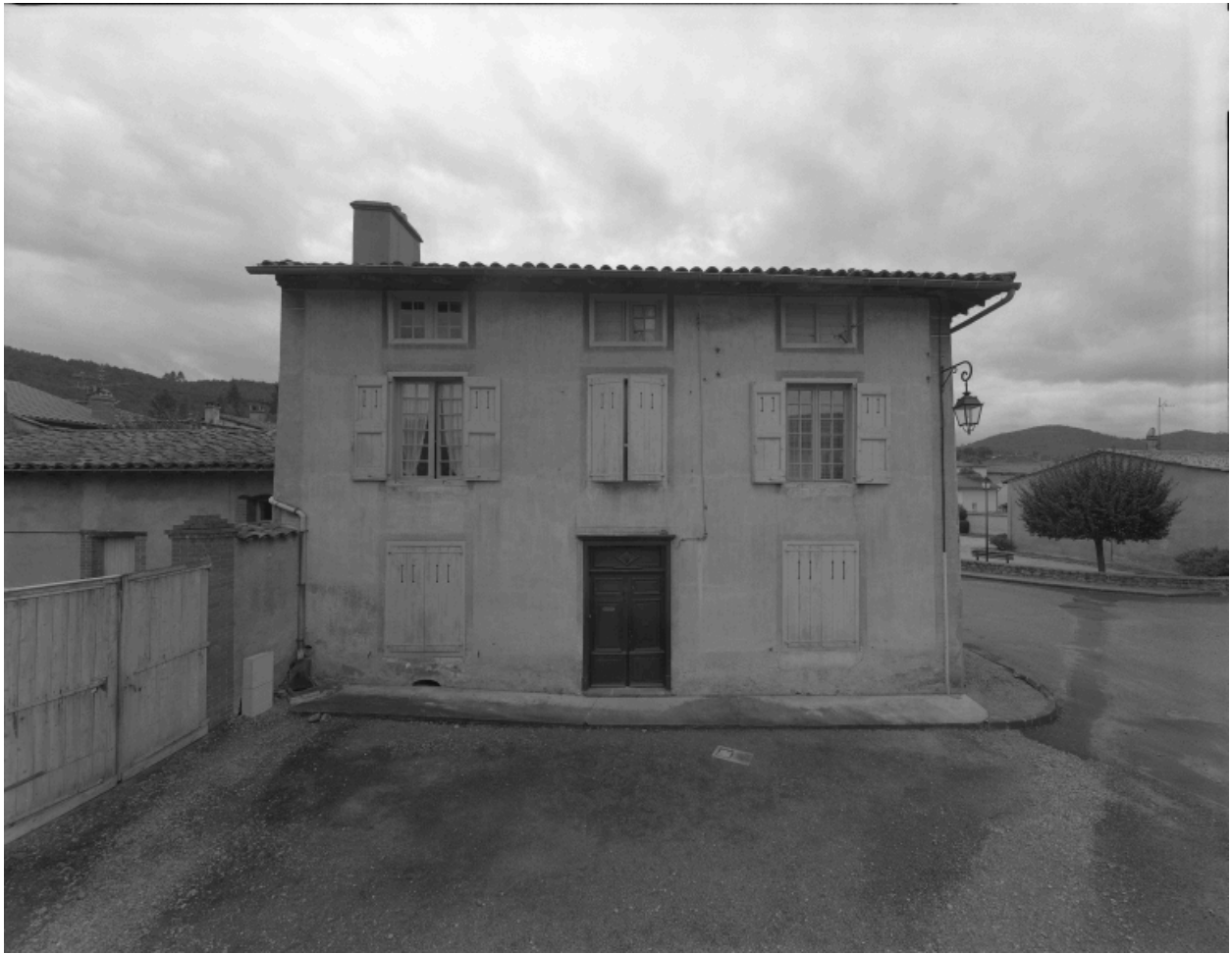
Vue d'ensemble de l'élévation antérieure.
