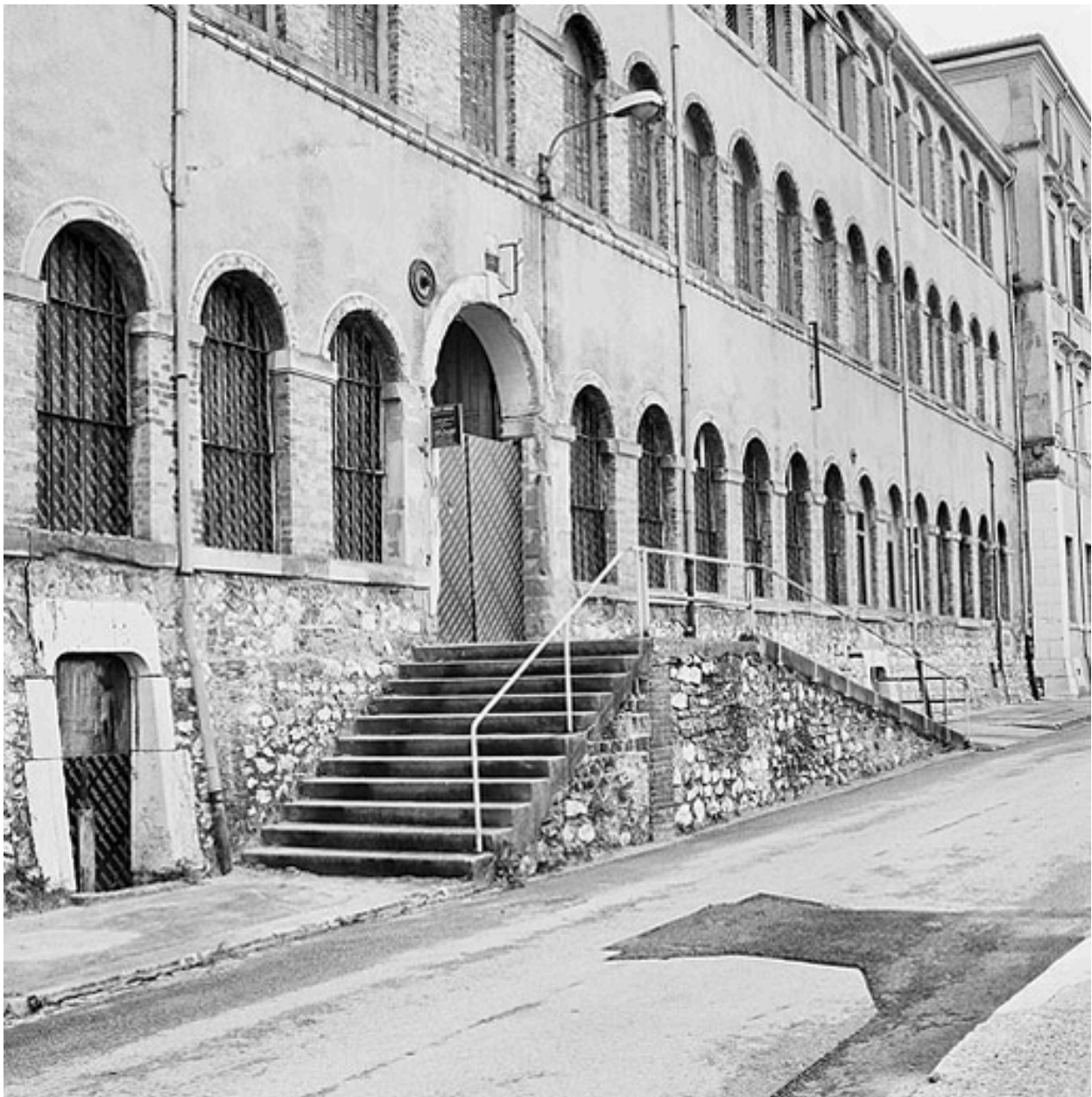
Escaliers extérieurs, façade ouest
