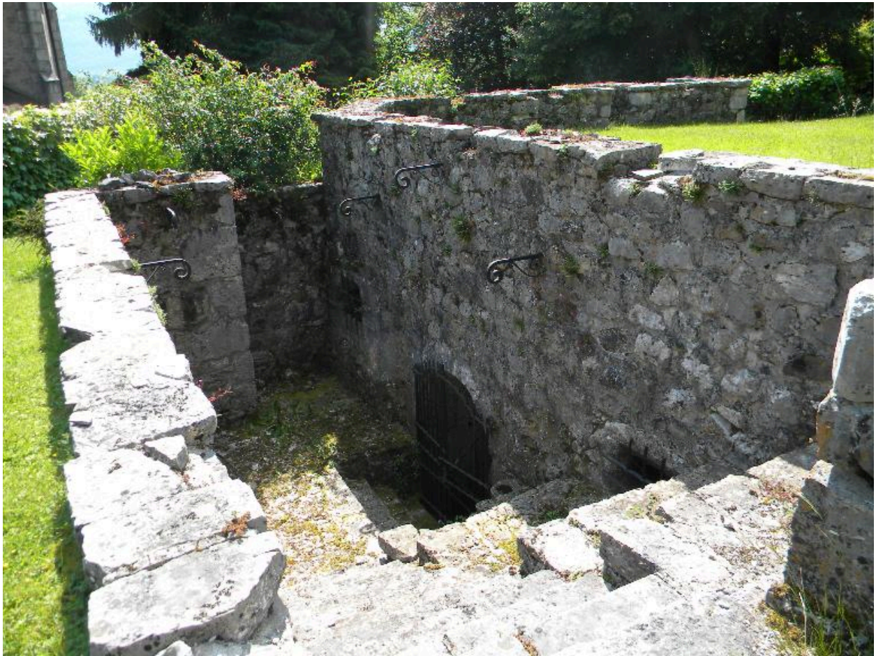
Vue de la descente d'accès à la cave.
