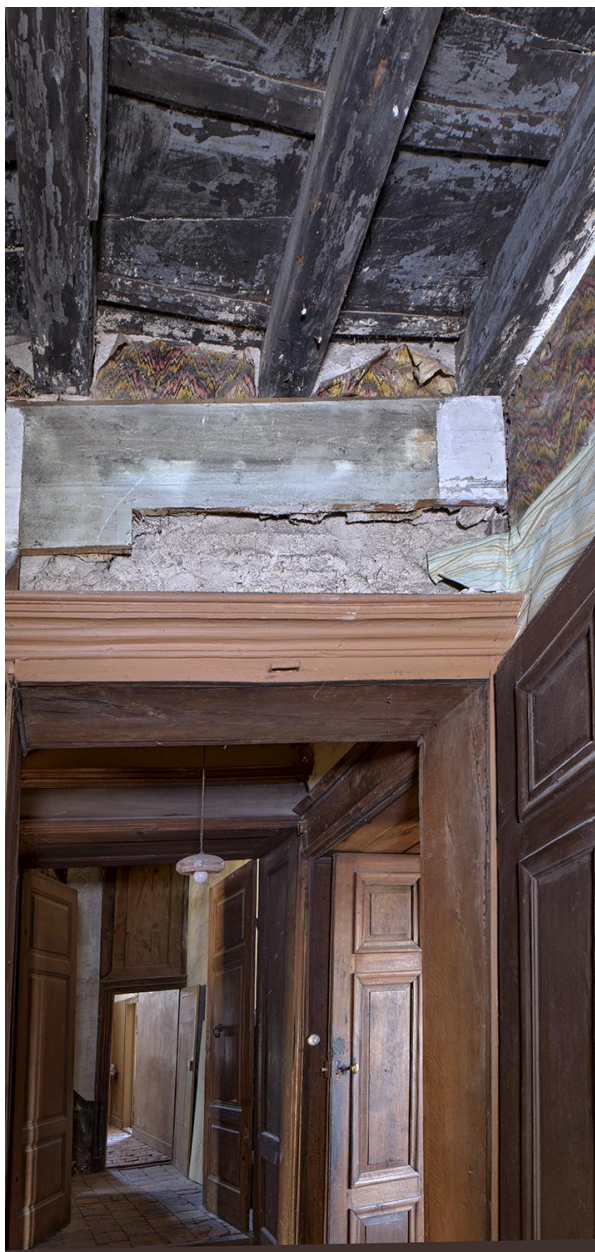
Etage carré de la maison, vue d'ensemble du dégagement entre les chambres 4 et 2.
