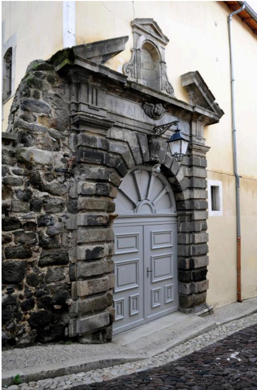
Porte principale vue de trois-quarts
