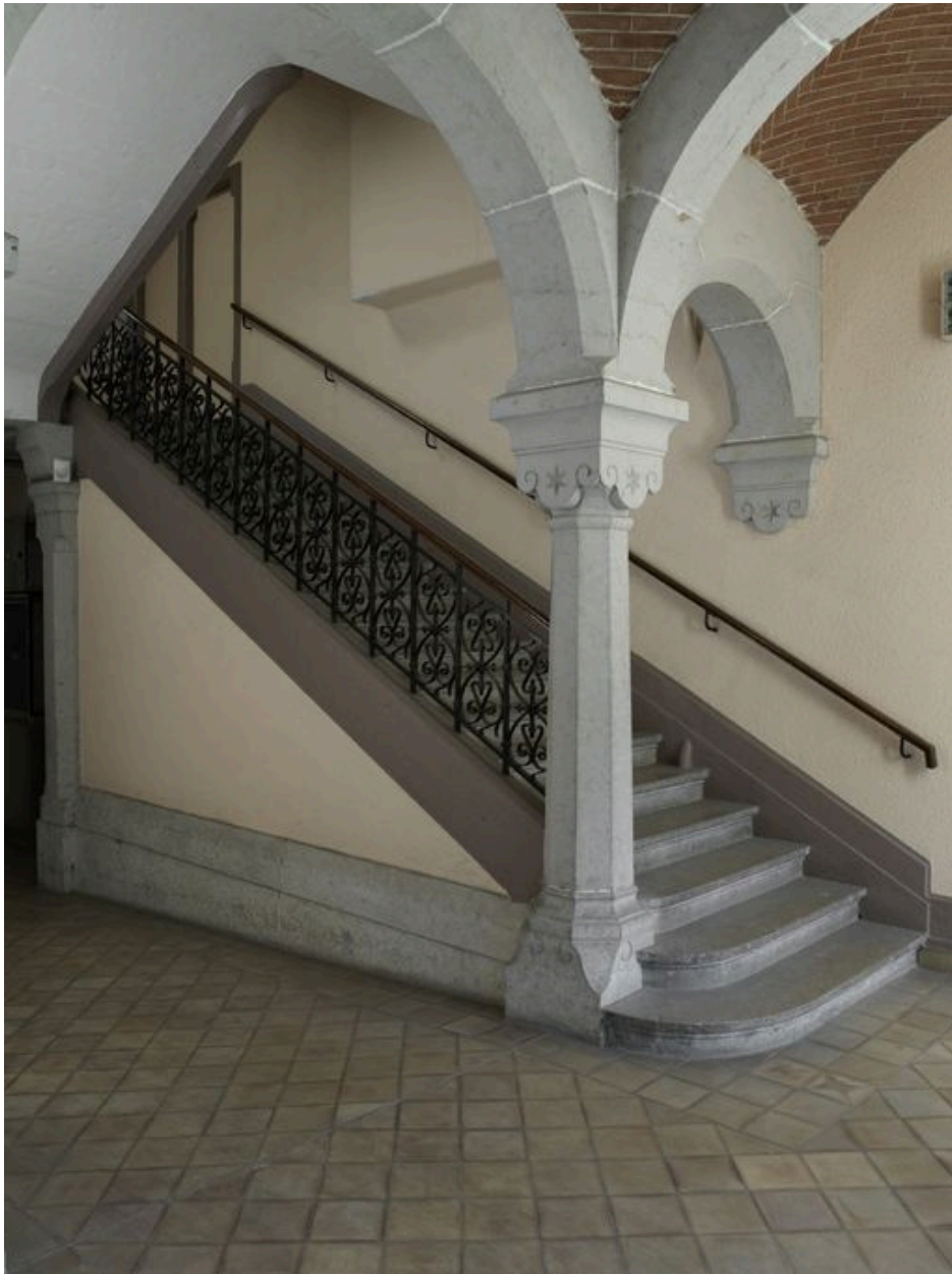
Escalier principal, première volée, montée de droite, vue latérale
